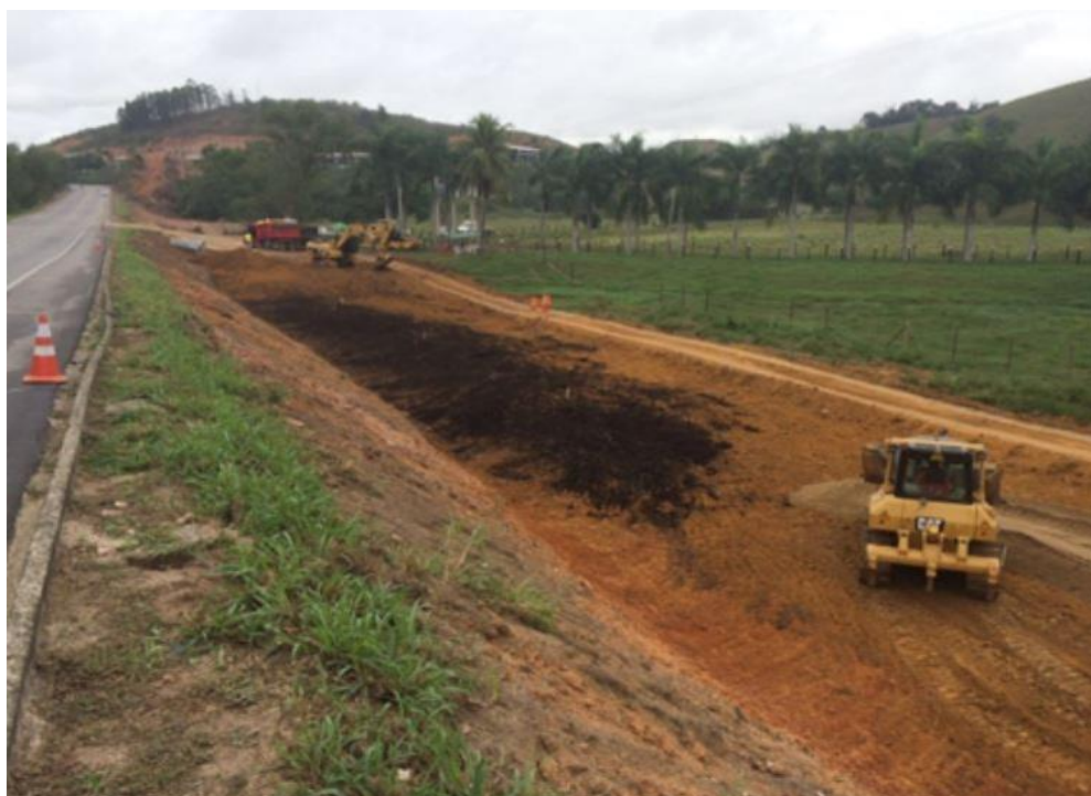
Figura 16: Contenção de taludes em margem de rodovias.
