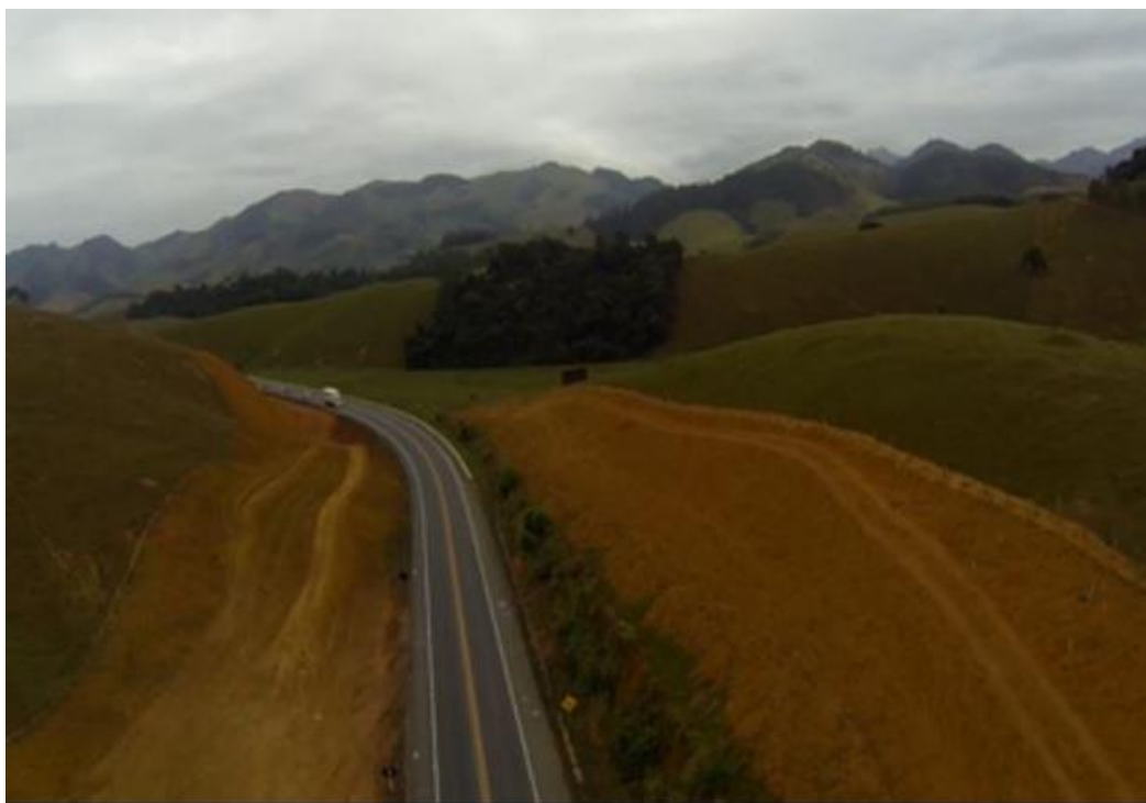
Figura 18: Contenção de taludes em margem de rodovias.
