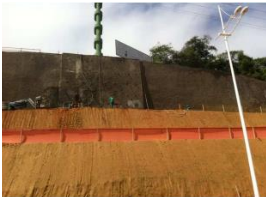
Figura 15: Uso de solo-grampeado para a fatia com 90°.
