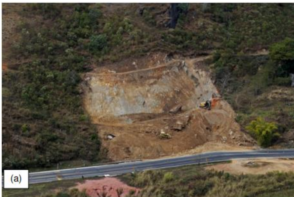
Figura 22: Obra de contenção de deslizamentos.
