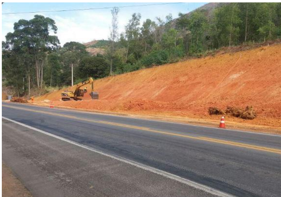
Figura 19: Contenção de taludes em margem de rodovias.
