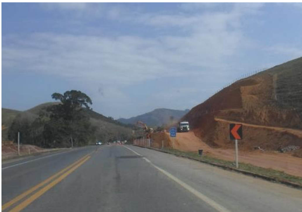
Figura 17: Contenção de taludes em margem de rodovias.
